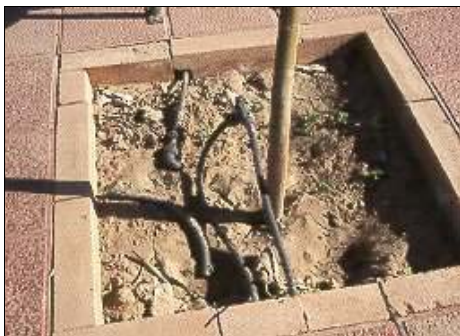
En aceras de nueva construcción es recomendable y más barato el riego por goteo
